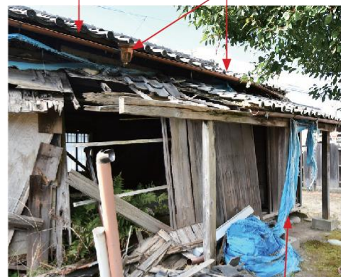
東面 下屋部分
