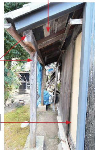
下屋 軒見上げ
