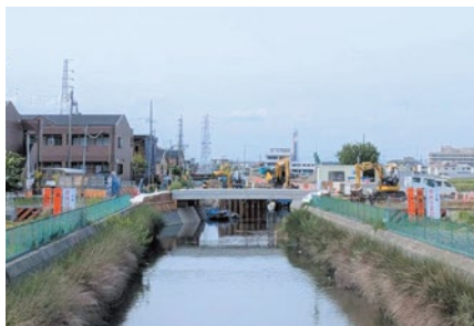
▲善太川の拡幅工事
