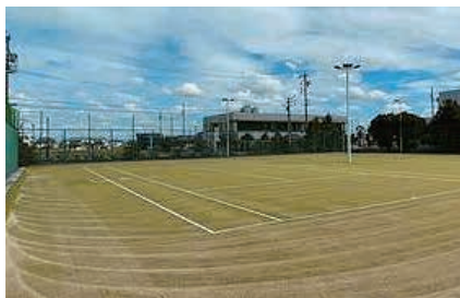
▲生涯学習センターオムニコートの全面改修
