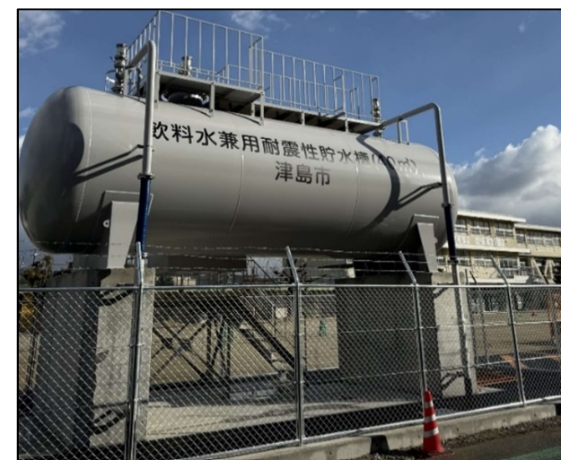
参考：神守小学校飲料水兼用耐震性貯水槽 （令和 7 年 2 月設置）
