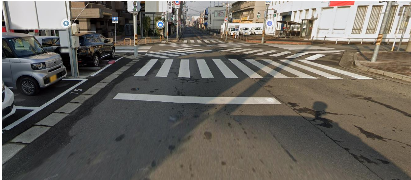
現場写真①（新設する路線 1）
