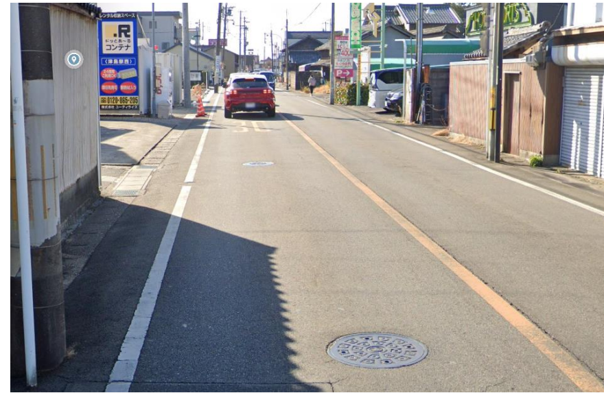
現場写真②（新設する路線 2）
