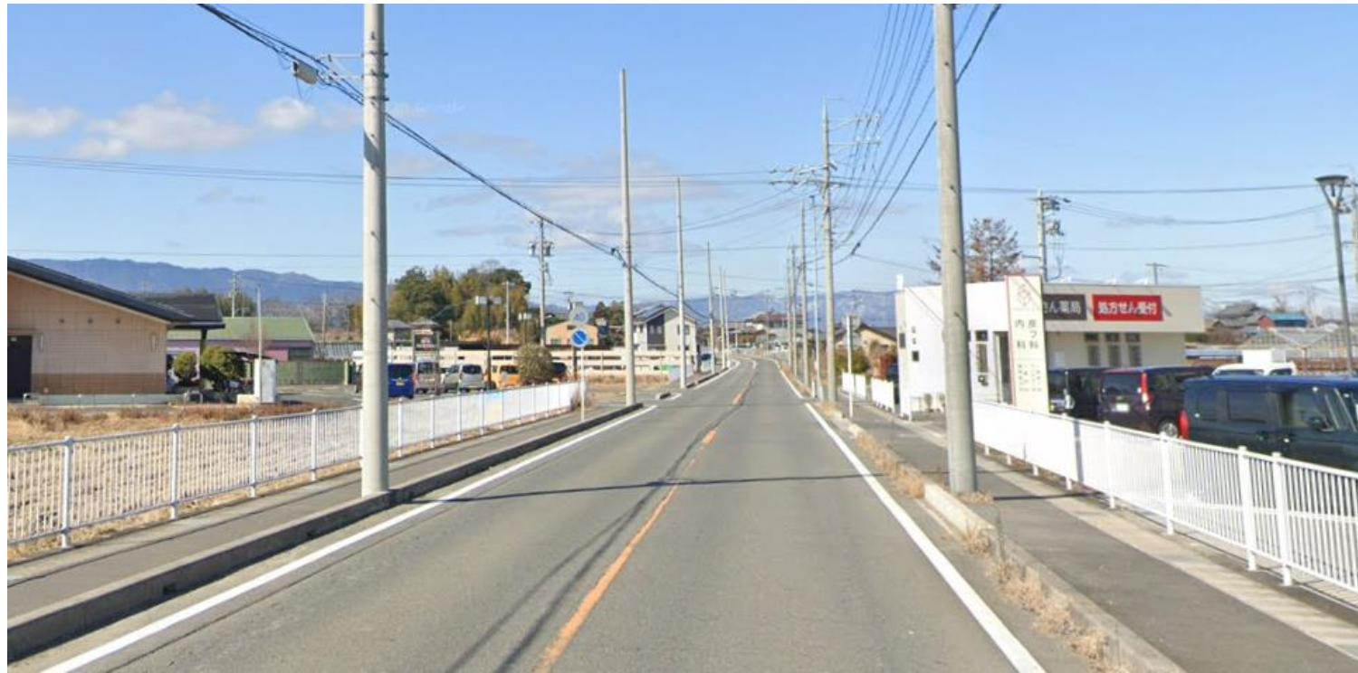
現場写真⑤（新設する路線５）
