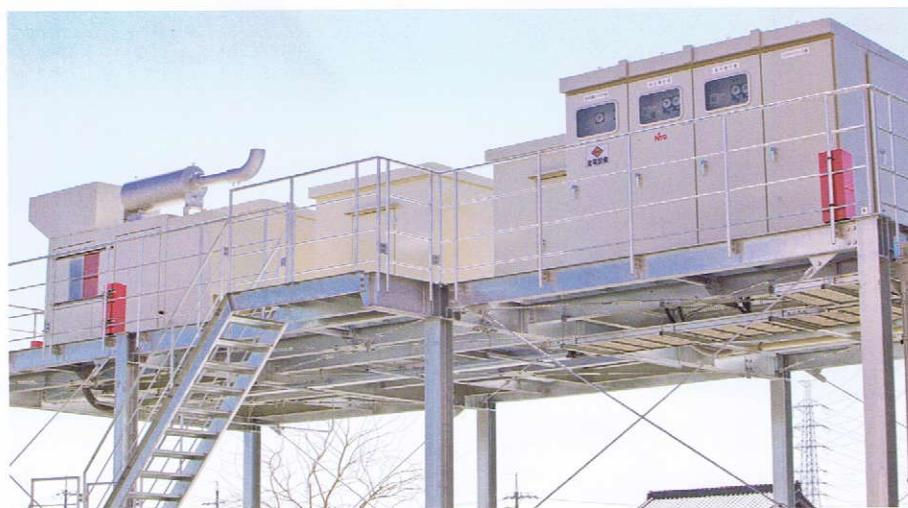
海拔 0 メートル以下のエリアが多い地域性から、液状化に対して優れた耐震性を有する基礎構造を施工した架台の上に設置し、災害非常時においても3日間（72時間）の安定的な電力供給を可能にします。
