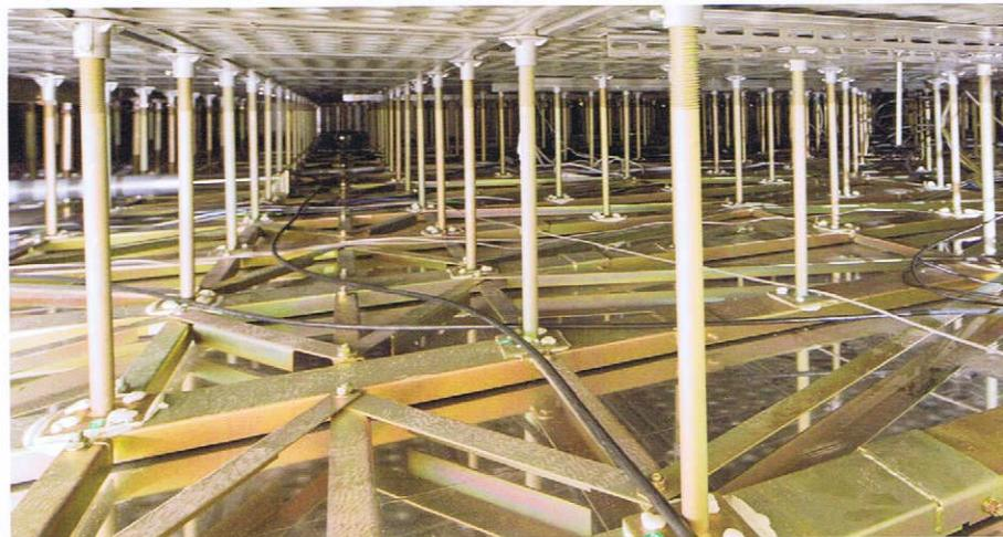
ボールベアリングが付いた免震フレームに載っています。
