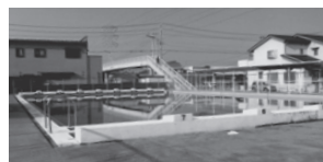
▲西小学校プール
