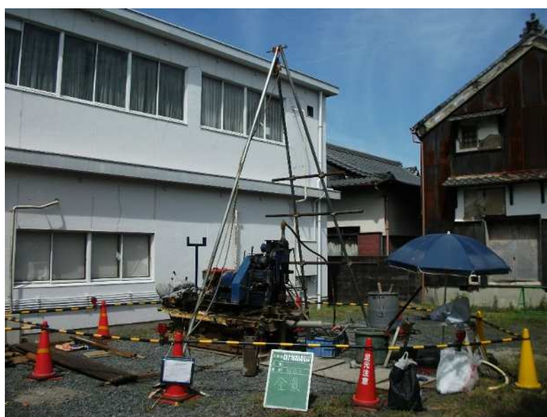
写真-3.1.1 ボーリング機械設置状況及び仮囲い
