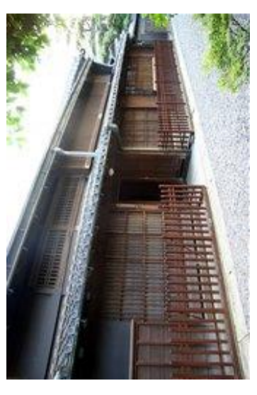
重要文化財 堀田家住宅
